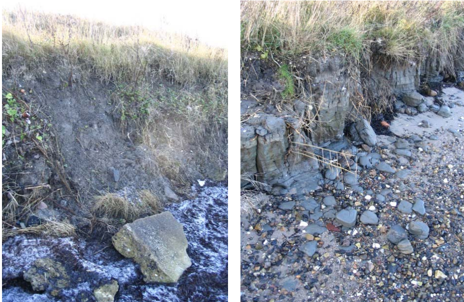
Figur 2.5 Langeraks brinker på to lokaliteter. Begge steder viser brinkerne tydelige tegn på erosion. På billedet til venstre har der for nyligt været et skred, som det fremgår af bevoksningen. På billedet til højre er der tydelig erosion i leret, idet der ligger afbrækkede lerklumper nedenfor brinken.
