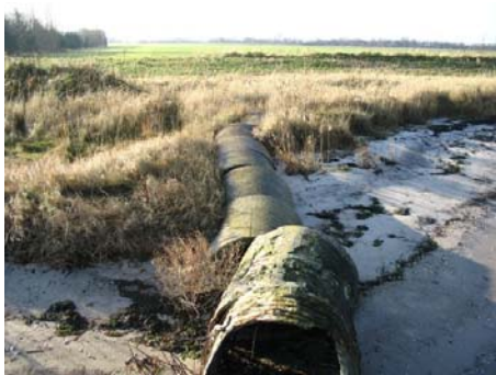
Figur 2.9 Høfde af brøndrør. Bemærk, at høfden har været i stand til at fange sand på begge sider
