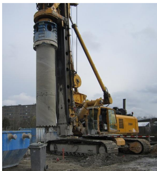
Figur 7-11: Sekantpæleboremskine og færdig sekantpælevæg, Nordhavnsvejens Tilkoblingsanlæg
