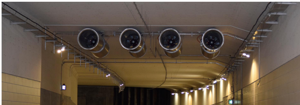
Figur 5-33: Tunnelventilatorer (NHV)
