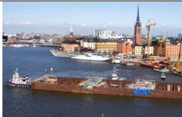
Figur 7-35 - Flådning af stålmembran for Söderström tunnel ( trafikverket.se ).
