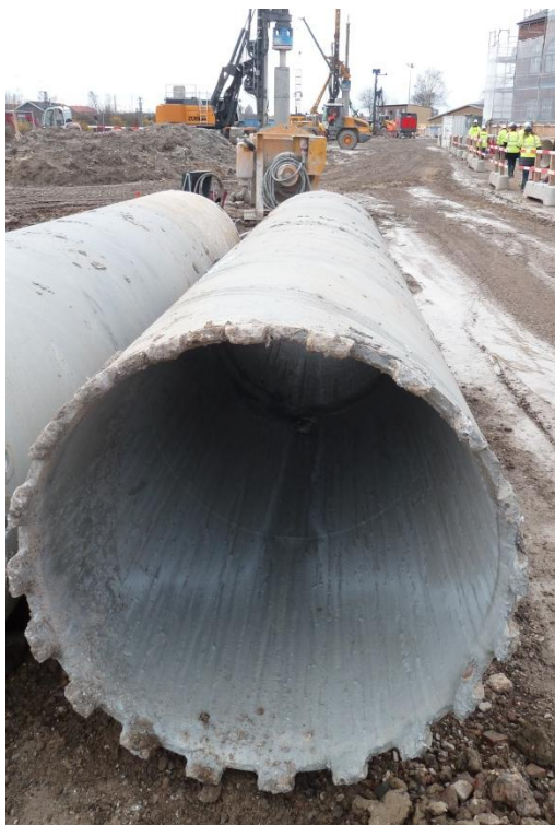
Figur 7-12 - Borehoved til kalk, tv, Armeringskurv for sekantpæl øverst th, Foringsrør nederst th.
