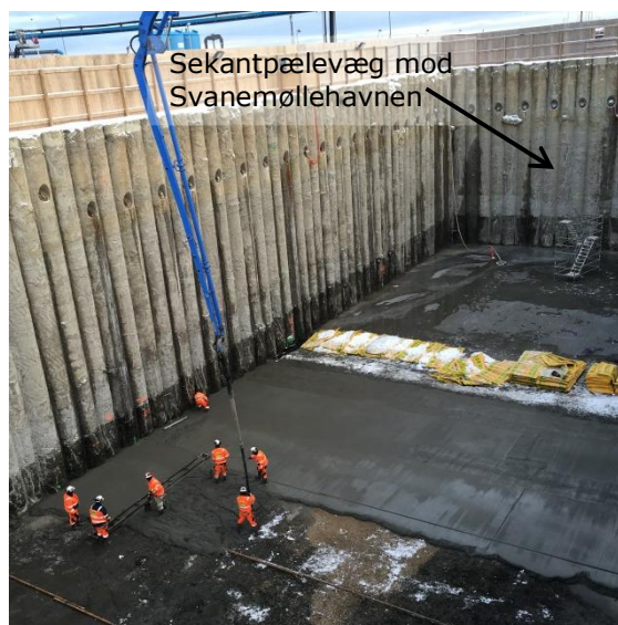
Figur 7-11: Sekantpæleboremskine og færdig sekantpælevæg, Nordhavnsvejens Tilkoblingsanlæg
