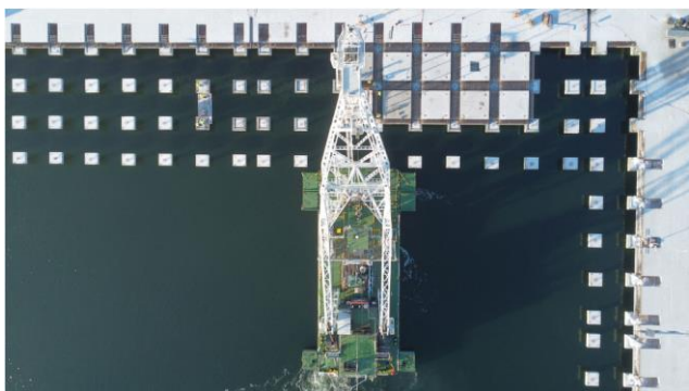
Pile caps er monteres på stålpile og installation af dækelementer pågår med flydekran (Varberg)
