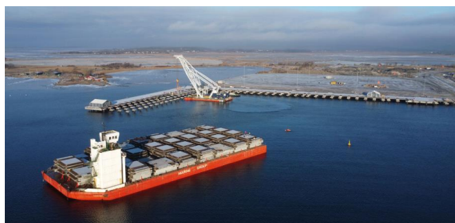
Levering af præfabrikeret dækelementer (Varberg)
