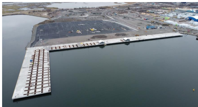
Dækelementer er monteres og udstøbning af samlinger pågår (Varberg)
