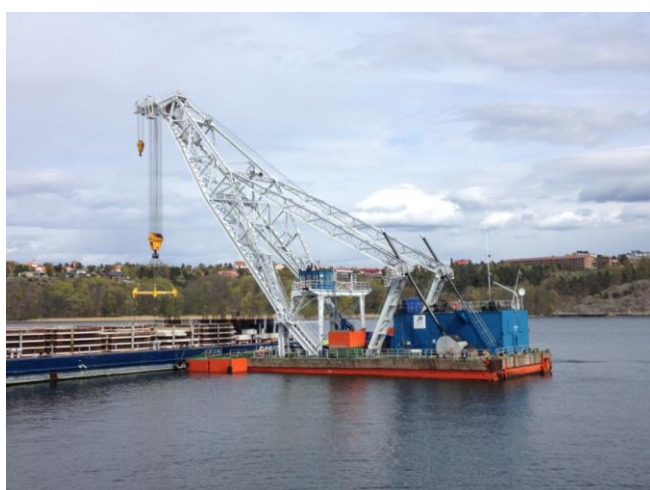
Løft af dækelementer fra lagerpram med Lodbrock (Värtahamnen)
