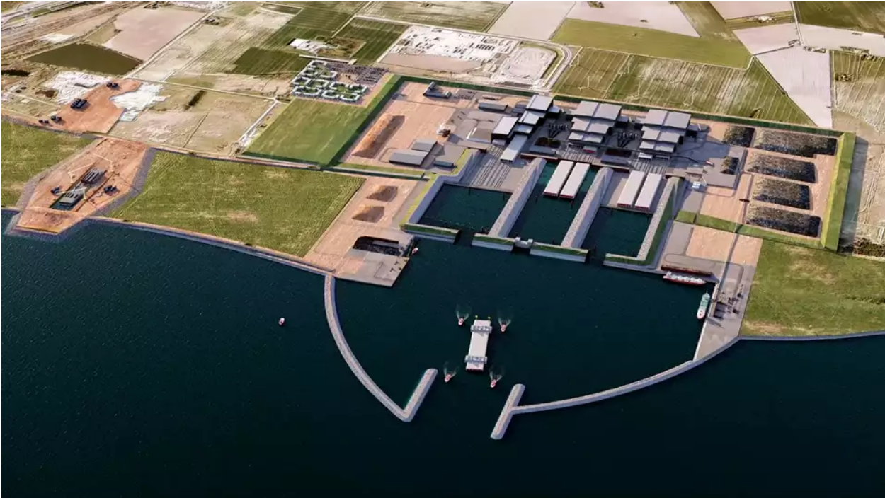
Figur 8: Illustration af tunnelementfabrikken
